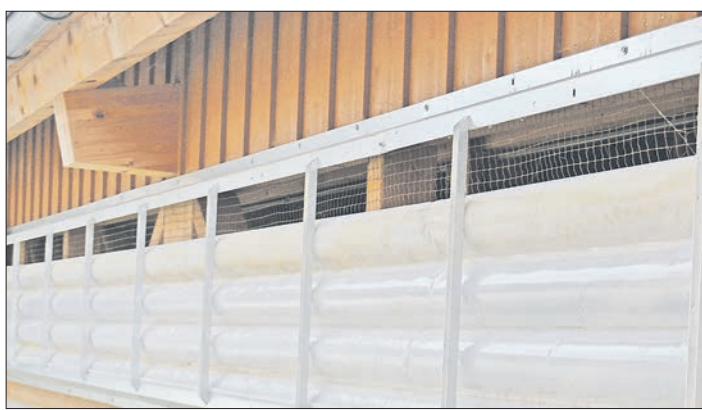
Die Lüftung ist einfach: Zwei gesteuerte Lüfter können individuell die Luftkammern aufblasen.
