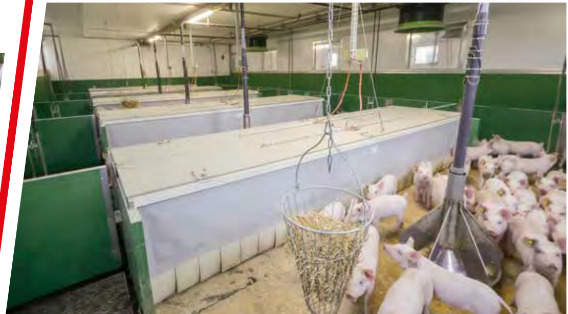
ATX® Aufzuchtstall mit mechanischer Lüftung
